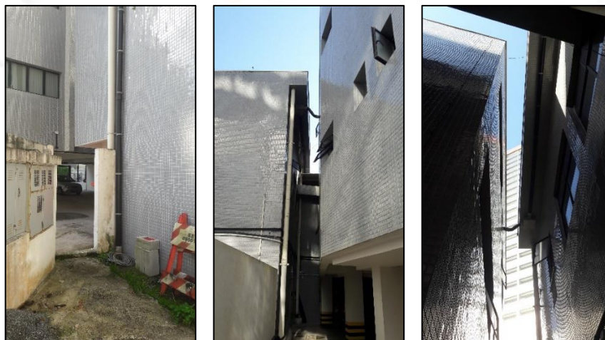
Figura 1 – Local onde será instalada a cobertura de policarbonato
