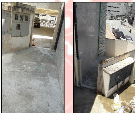
Figura 6 – Concretagem do piso do bicicletário
